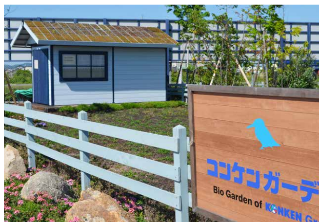
コンケンガーデン敷地内に設けられた防災資機材の備蓄倉庫
